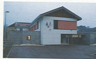
Nouveaux bâtiments du groupe scolaire
